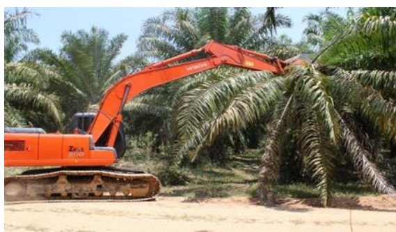
ผู้รับจ้างนำเครื่องจักรเข้ารื้อถอนทำลายต้นปาล์มน้ำมันท้องที่ ตำบลปลายพระยา อำเภอปลายพระยา จังหวัดกระบี่
