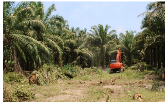
ผู้รับจ้างนำเครื่องจักรเข้ารื้อถอนทำลายต้นปาล์มน้ำมัน ท้องที่ ตำบลปลายพระยา อำเภอปลายพระยา จังหวัดกระบี่
